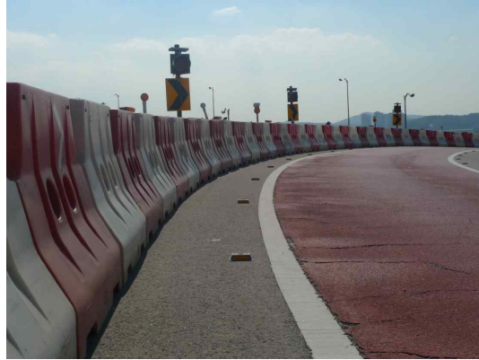
<그림 5.8> PE 울타리 설치 예
